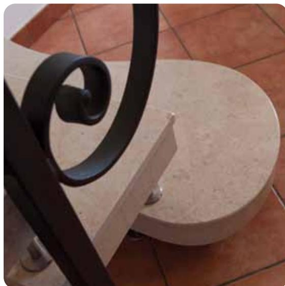
Particolare del sistema di ancoraggio al solaio tramite tiranti in acciaio verniciato.
